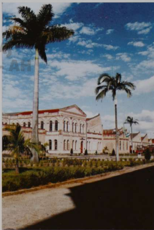
Conjunto arquitetônico da Antiga Companhia Paulista de Estradas de Ferro, Jundiaí, SP, 1999. Fonte: Secretaria Municipal de Planejamento e Meio Ambiente/ Prefeitura do Município de Jundiaí.
