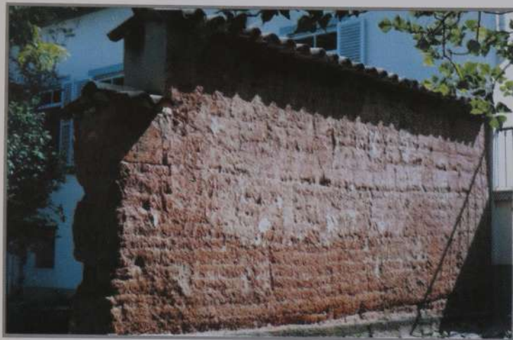
Parede externa de taipa do pilão do Solar, 1999.
