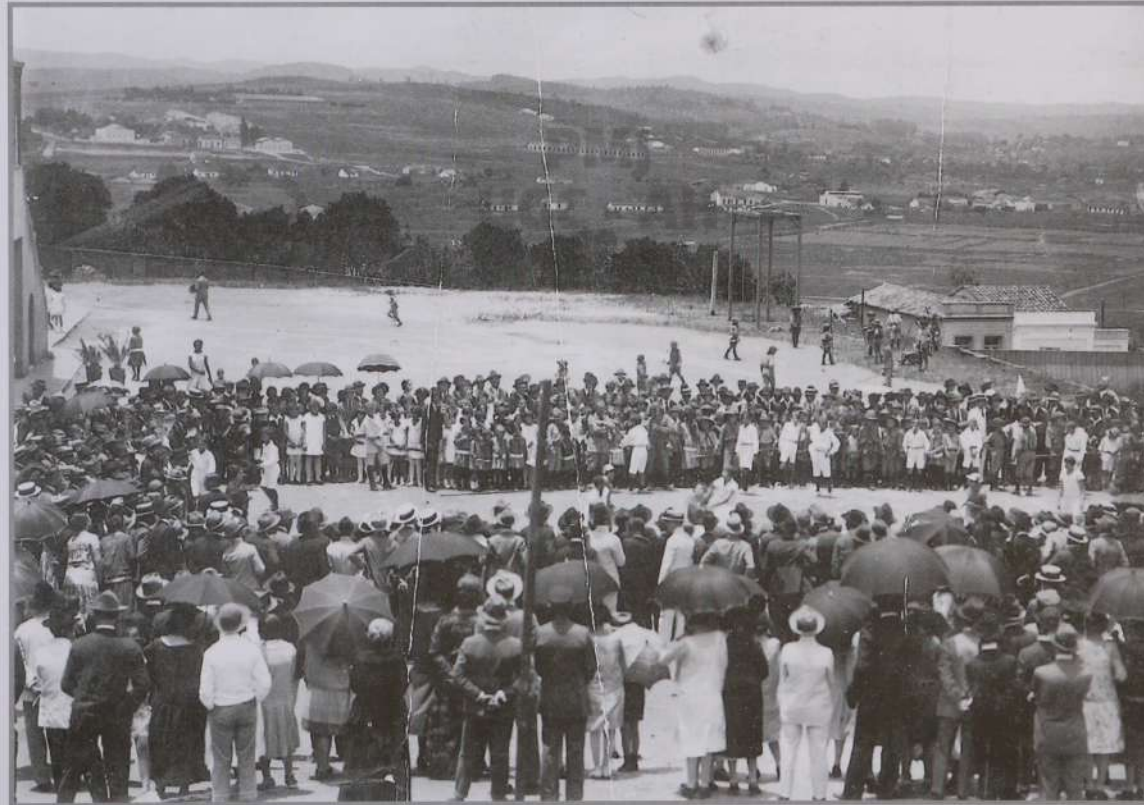
Lançamento da pedra fundamental do Grupo Escolar Conde do Parnahyba, em 27 de abril de 1920.
