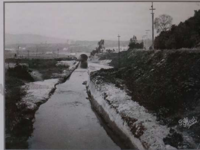
Década de 1930, por ocasião das obras de retificação do rio Guapeva.
